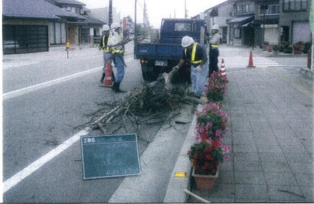
写真タイトル：作業状況 撮影箇所：出町けやき公園
