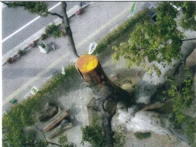
工種：剪定工 写真タイトル：養生状況 撮影箇所：出町けやき公園
